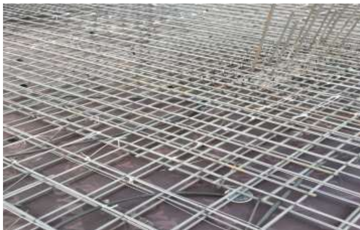
Рисунок 8 – Устройство проводок в монолитном перекрытии
